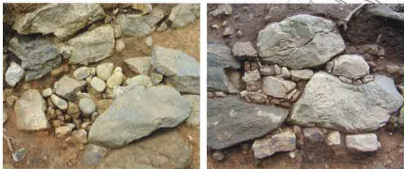
③石垣Ⅱ前に設けられた石拵 ④精微に詰められた間詰石
