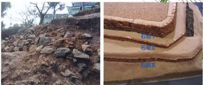
⑦3段目の石垣(石垣Ⅲ) 推定復元模型による3段石垣のイメージ
