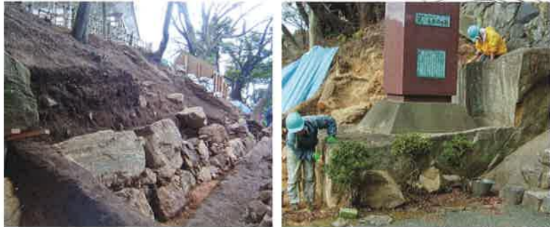
①残存するのは基底部付近の2~3段でさらに3~4段石垣が積まれていたと推定される ②主郭大手脇には花崗岩巨石を配置
