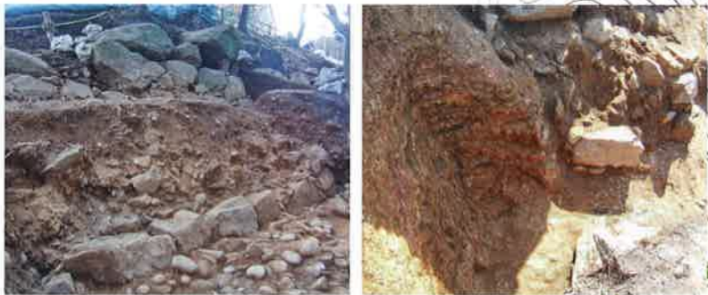
⑤段築された石垣(石垣Ⅰ・Ⅱ) ⑥岩盤加工の入隅と石垣
